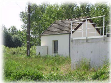
Captages d'eau potable de Nogent-sur-Seine.
