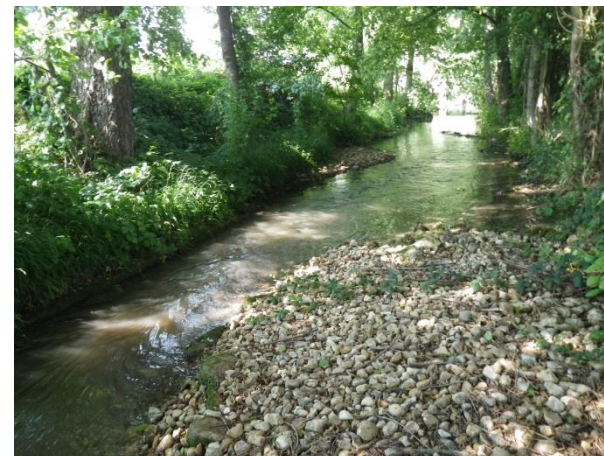
Ru du Cuivre après travaux (Août 2013)
