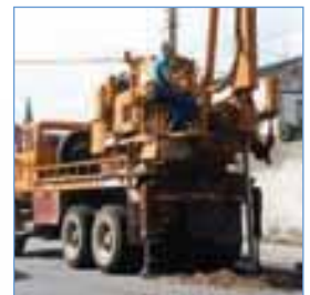
Etude géotechnique phase 2 : sondeuse
