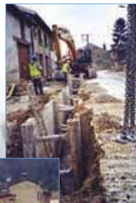
Pose d'un réseau d'assainissement Haute-Marne 2003
