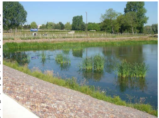
Un bassin de retenue des eaux pluviales partiellement rempli.
