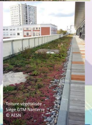
Nouve étanchée en présence de gypse substrat au-dessus d'une géo-membrane, réservoir d'eau pour les végétaux
