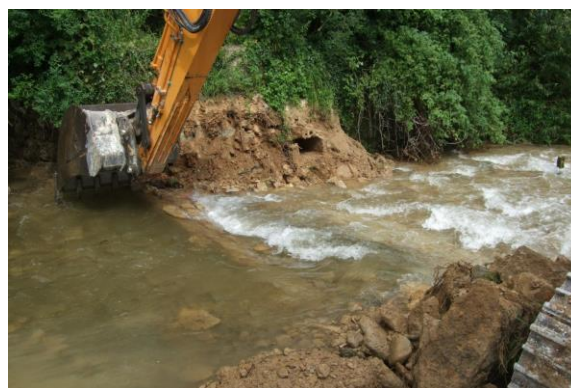
Effacement d'ouvrage sur la Blaise (52) Maitre d'ouvrage : SIAH Vallée de la Blaise
