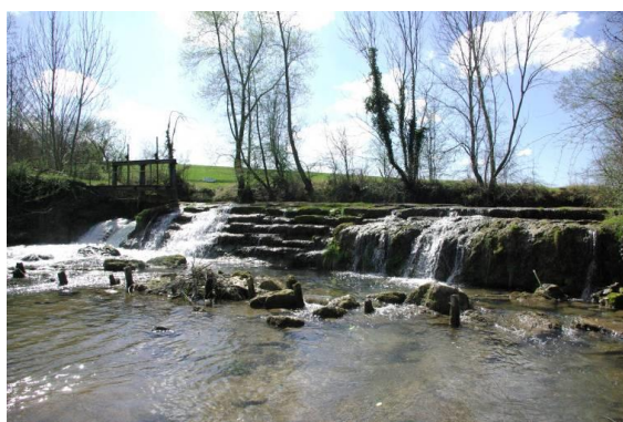
L'ouvrage était obsolète et en très mauvais état. Les travaux ont eu lieu en 2013
