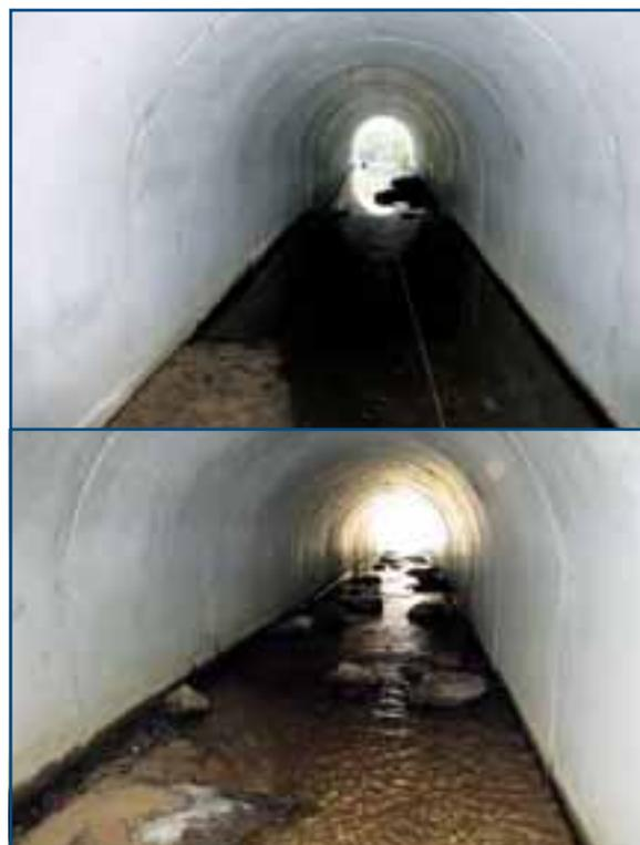
↑ **Figure 103** : Exemple d'un « tunnel » de franchissement avant travaux de diversification du lit en haut et après « réaménagement » en bas. ≡
