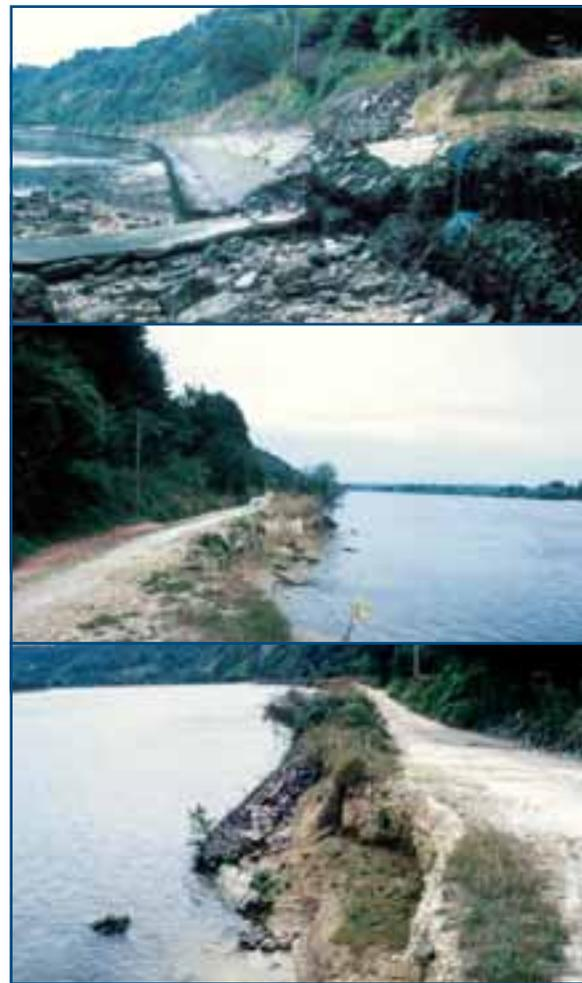
↑ **Figure 70** : (18.08.00) Etat initial de l'érosion avant les travaux de réfection de la berge, juste à l'aval de perrés existants maintenus et d'anciens gabions détruits par les contraintes du site. ≡
