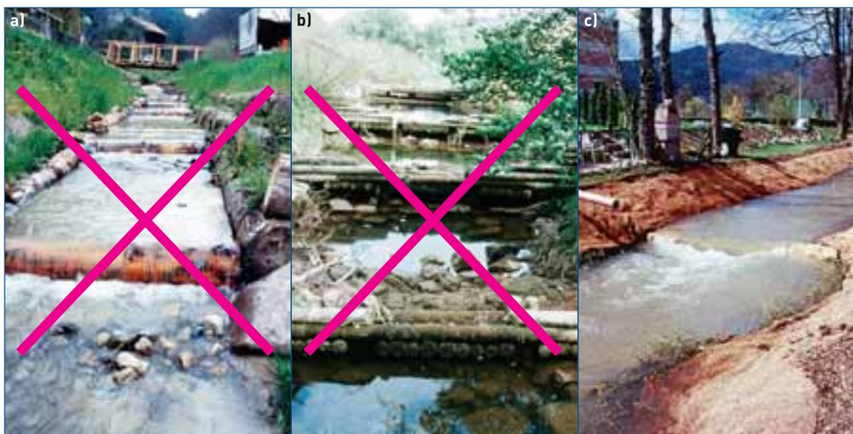
↑ **Figure 22 : a) et b)** Seuils en rondins de bois (à déconseiller). **c)** Seuil en enrochement (à conseiller). En effet, selon nous, la mise en place de seuils en enrochements permet un rendu plus respectueux des processus naturels, en limitant la largeur de la lame d'eau. 🌊
