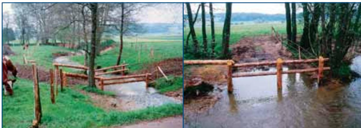
↑ **Figure 102** : Exemples d'aménagements pour éviter que le bétail n'ait accès à l'ensemble des rives d'un cours d'eau. ≡
