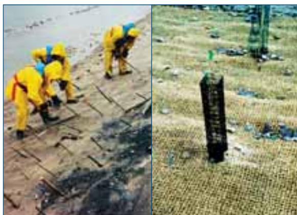
↑ **Figure 4** : Boutures de saules en travaux à gauche et plantations d'arbustes avec protection anti-rongeurs à droite. 🌊
