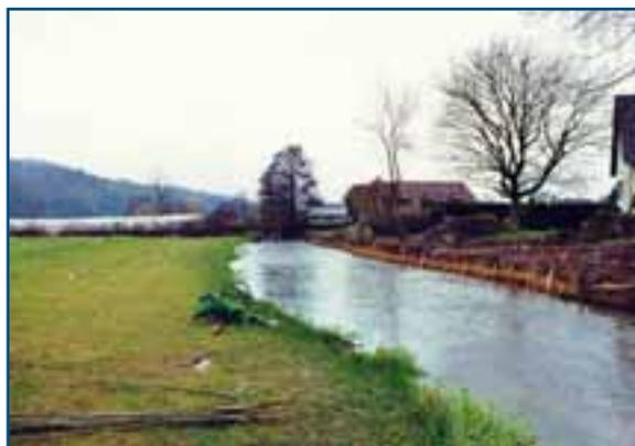
↑ **Figure 82 :** (27.02.07) Aménagement encore en cours à Croville avec suppression des merlons, recharge alluviale, adoucissement de la berge gauche au droit des parcelles agricoles et techniques du génie végétal (ici alternance de tressages de saules et de fascines d'hélophytes) en rive droite . ≈
