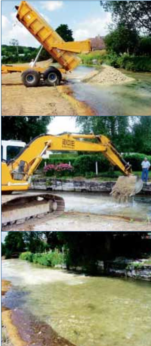
↑ **Figure 20** : Exemples de travaux de recharge alluviale sur la Scie (76), avec mise en forme des matériaux apportés. ≈
