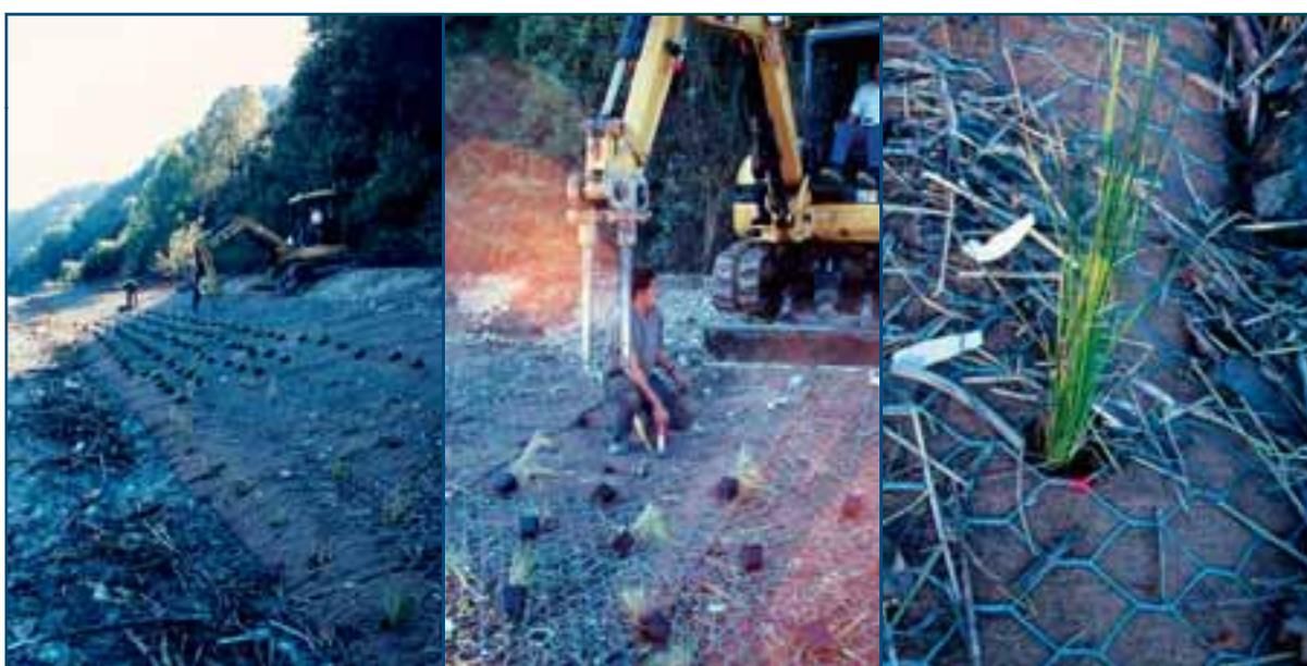
↑ **Figure 75 :** (27.10.05) Les hélophytes sont « prédisposés » sur la berge et plantés entre les mailles du treillage métallique avec une légère découpe préalable des géotextiles biodégradables. Le treillage métallique en couverture est ensuite agrafé avec des « doubles agrafes » métalliques. ≡
