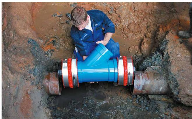
Raccordement de canalisation de branchement sur la canalisation.
