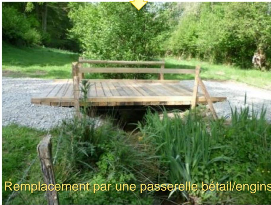
Remplacement par une passerelle bétail/engins
