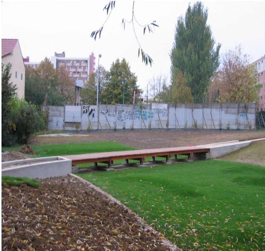
Parc inondable de la Saussaie (Saint Denis) : les eaux pluviales sont stockées dans un espace vert
