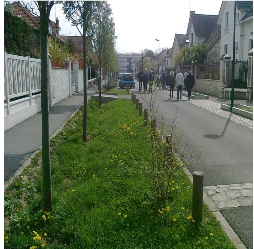
Vaires-sur-Marne : les eaux de ruissellement de voirie s'écoulent dans un espace vert linéaire en noue qui irrigue les arbres d'alignement
