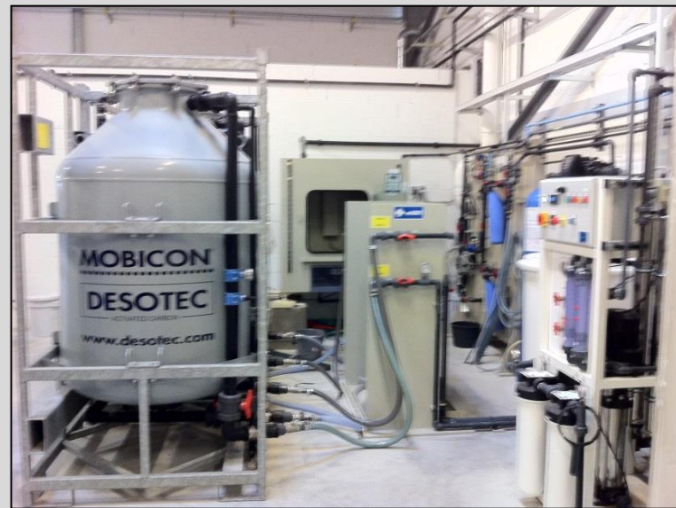
Unité de traitement du ressuage par charbon actif
