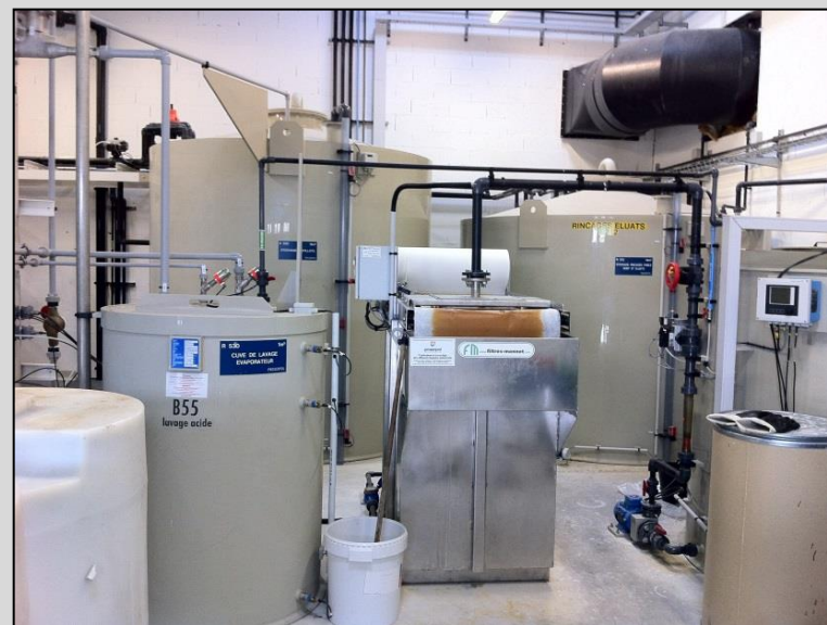
Stockages distillat et rinçages avant traitement
