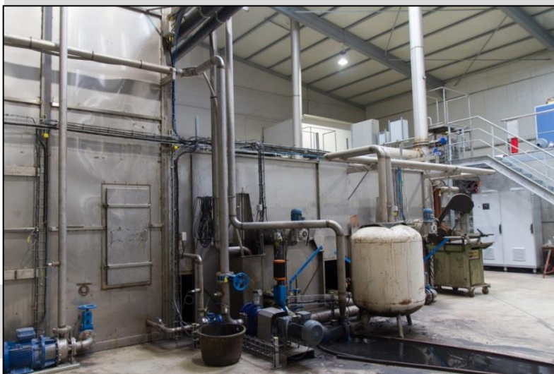
Concentration phase liquide du digestat
