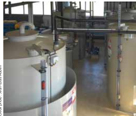
Station de traitement physico-chimique de l'eau
