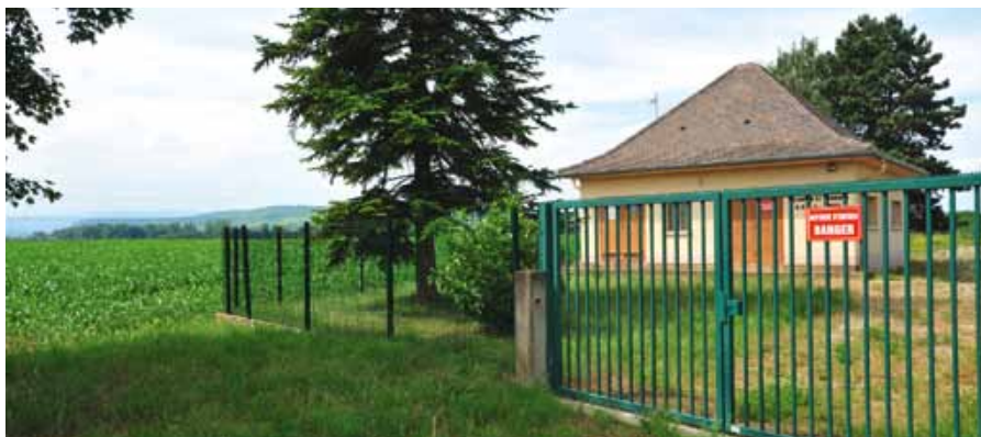
Captage d'eau potable
