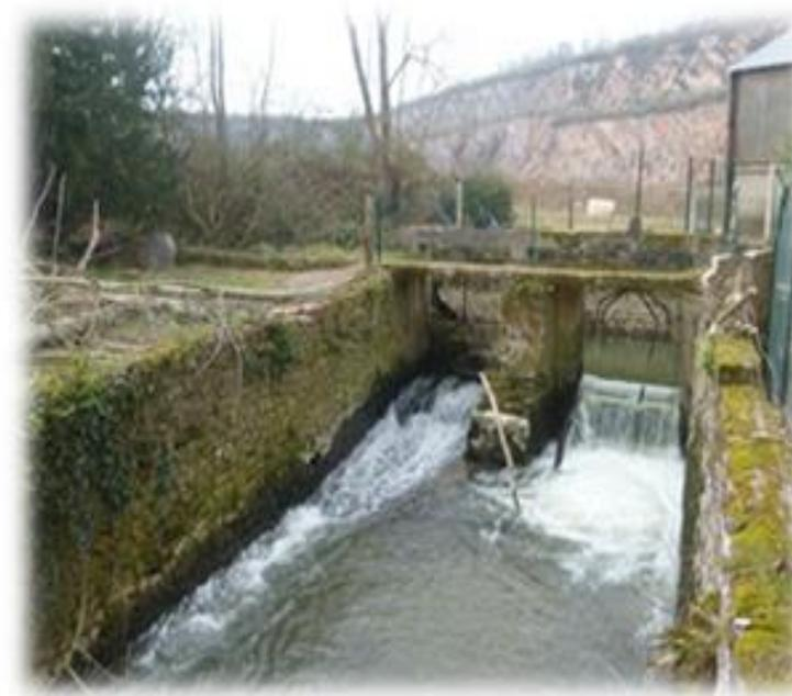
Figure 5 : Vannage de décharge
