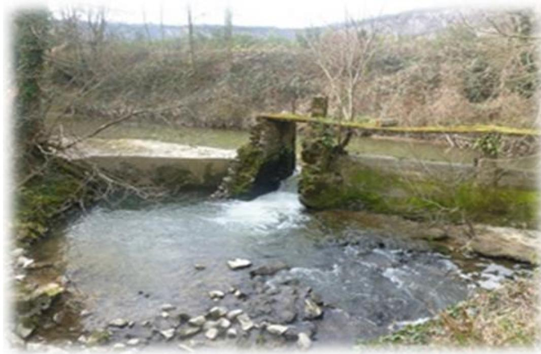
Les murs de soutènement en rive gauche et en rive droite, après le seuil de dérivation, sont démolis et un retalutage est réalisé avec une pente de 1/1
