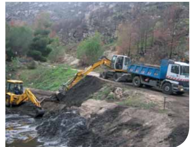
Curage d'un bassin à ciel ouvert. Photo D. Laplace - SERAM
