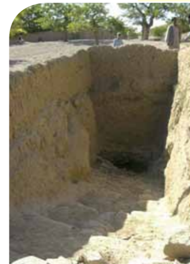
Intérieur d'une qanat (tunnels d'eau). Cette technique permet de faire transiter l'eau des montagnes de façon souterraine et de la récupérer un peu plus bas dans la vallée
