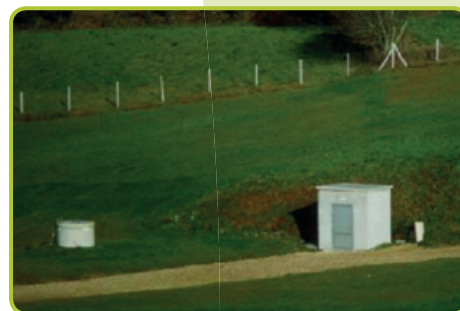
Station de mesure et point de prélèvement en eau souterraine
