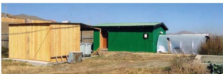
compostage résulte de l'assemblage de 2 containers bien isolés. Cette isolation étant insuffisante, un puits canadien a été construit pour utiliser la chaleur de la géothermie sous la zone de terre gelée. Ainsi, l'air récupéré est à une température suffisante pour amorcer le compostage.
