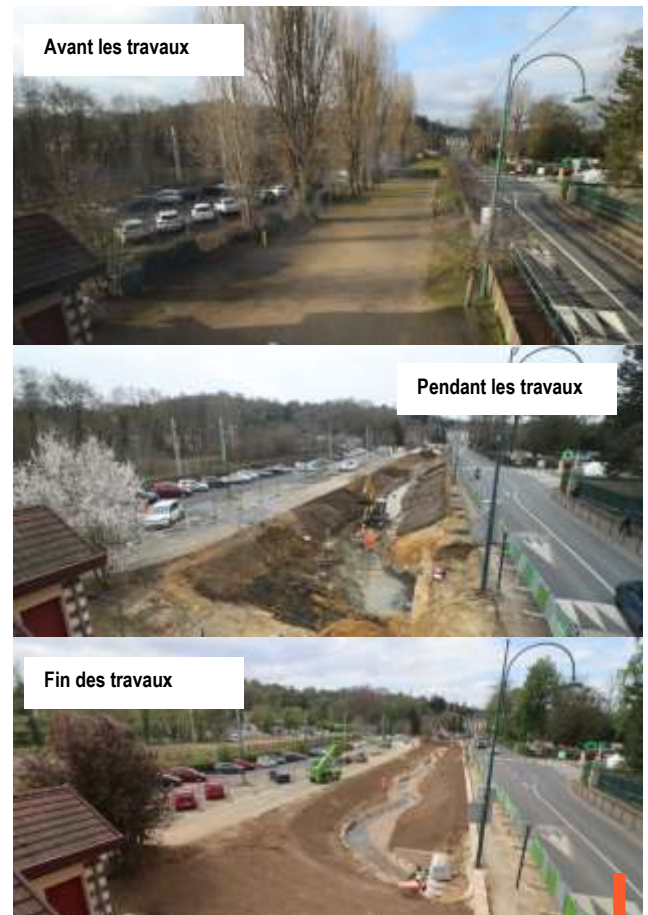
Réouverture de la Bièvre sur le boulodrome
