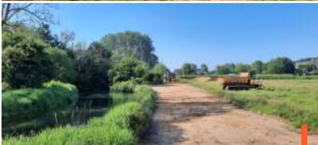
Arasement de merlons
