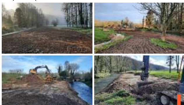
Déblaiement pour création d'une zone humide
