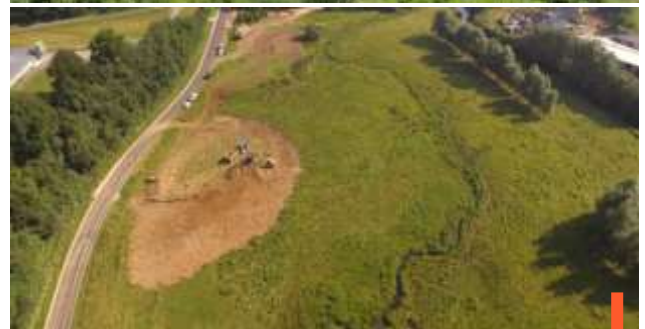
Décapage des atterrissements
