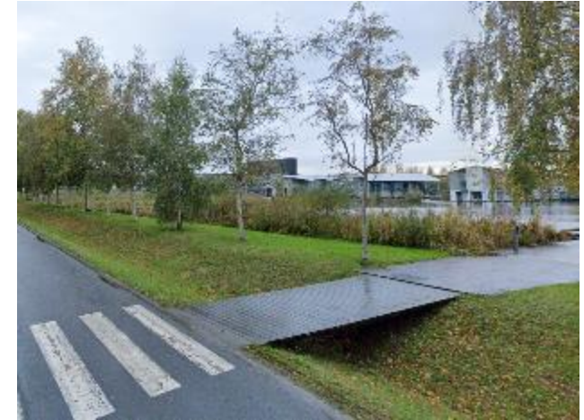
Noues de stockage et d'infiltration
