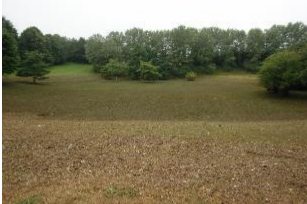
Bassin paysager de la Vallée des Jardins, parc paysager modelé pour gérer les pluies d'occurrence 30 ans
