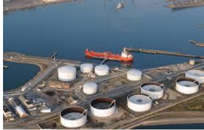
Traitement des micropolluants (BTEX) de la CIM au Havre
