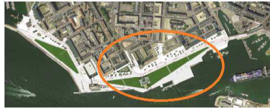
Gestion alternative des eaux pluviales du Quai Southampton au Havre
