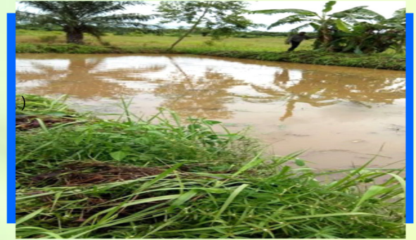
Mare de rétention d'eau: à fond non étanché, facilitant l'infiltration
