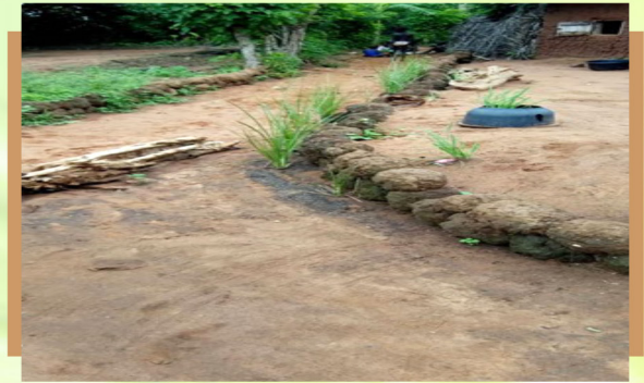
Digue de sable renforcée de plant anti-érosif: protège les cases contre l'érosion
