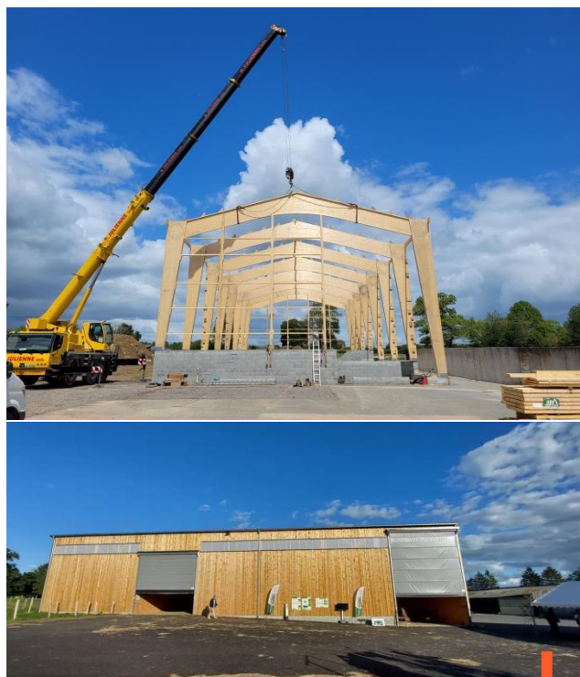
Construction du séchoir tout en bois éco durable Surface de 640 m 2
